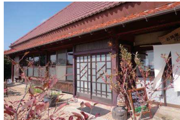
外観：屋根は既存を使用し玄関・縁側の建具は木製を使用し、昔の趣を生かした外観とした。
