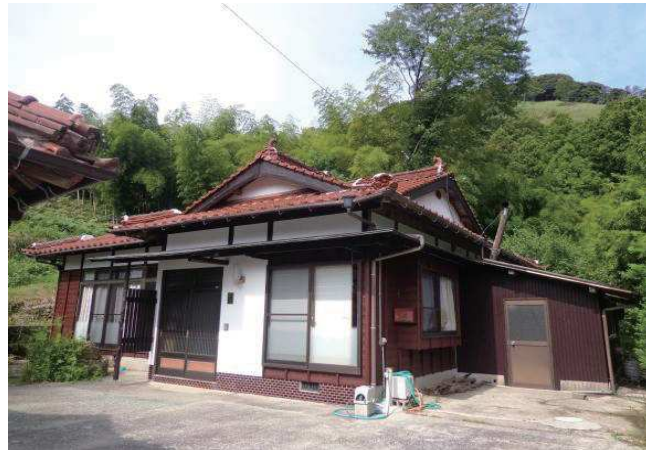
外観：雪の重みで樋が破損したため取替え、傷んでいた外壁を塗装
