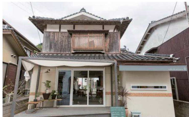
外観：1 階部分のみを改修。外壁を白くし木製デッキを設け明るくしている。
