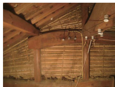
耐震壁調査: 耐震壁は土壁
