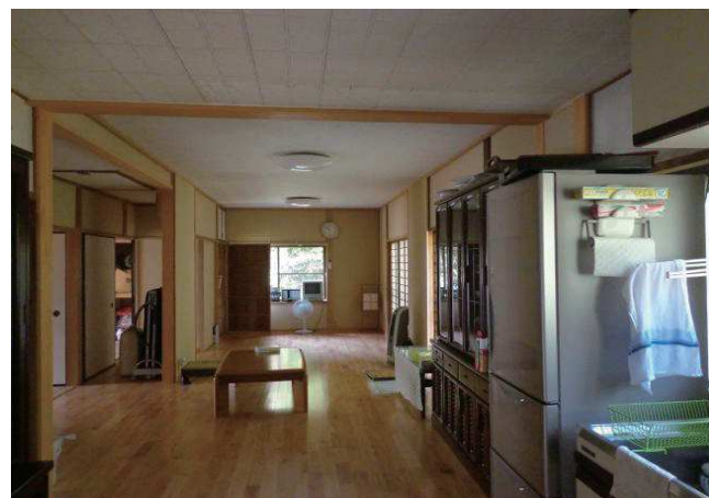
小さく区切られた廊下と和室、台所の壁を撤去し、家族がくつろげる19畳のリビング・ダイニングへ
