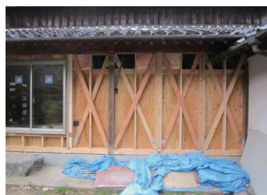
土壁だった耐震壁を外側を筋かい・内部を構造用合板で補強
