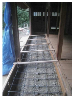
基礎を鉄筋で補強
