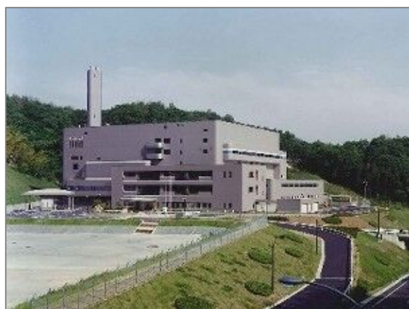
周南地区衛生施設組合 「恋路クリーンセンター」
