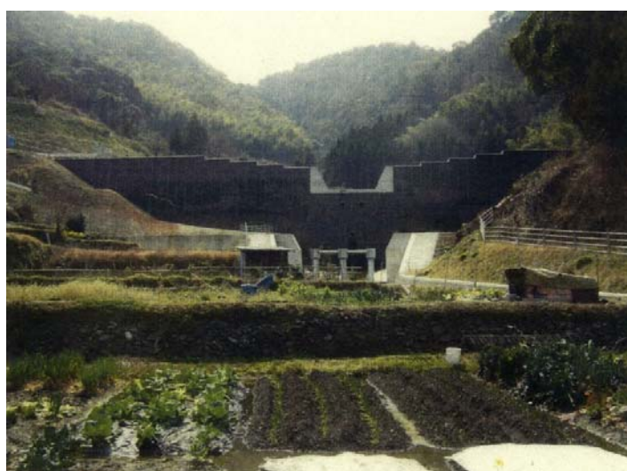
本浦地区砂防ダム
