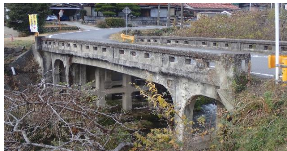
<下谷幹線【米川橋】>
