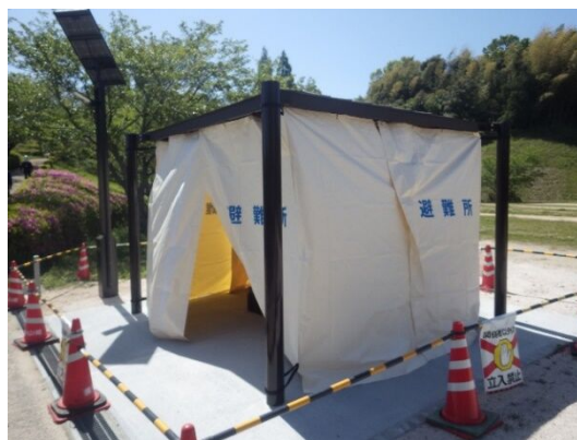
防災東屋(下松公園)
