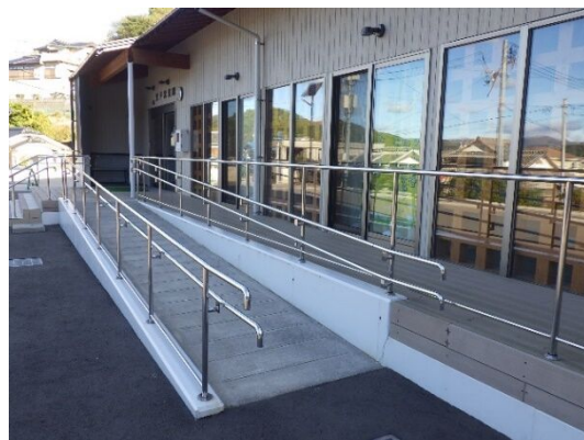
玄関のスロープ(笠戸公民館)
