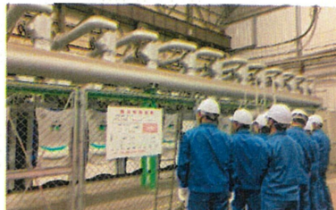
ボイラーの燃料転換と CO 2 回収装置の設置
