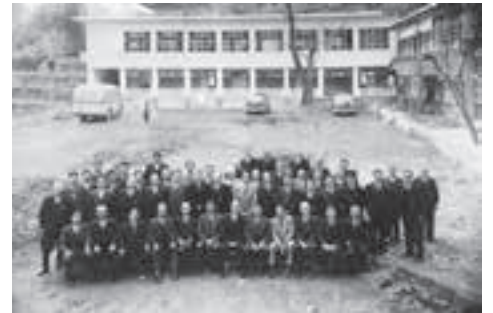
昭和30年、旧校地での新校舎落成式 （現在の米川公民館）
