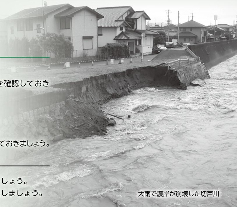
大雨で護岸が崩壊した切戸川
