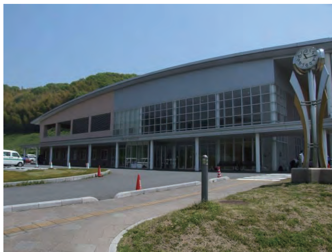
下松スポーツ公園体育館
