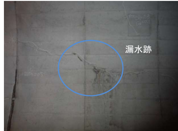
側壁のひび割れ状況 (S-005 上り側)
