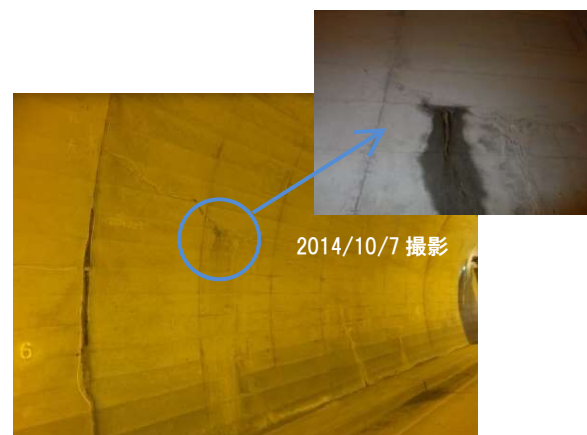
漏水跡の変状 (S-005 側壁部 上り線)
