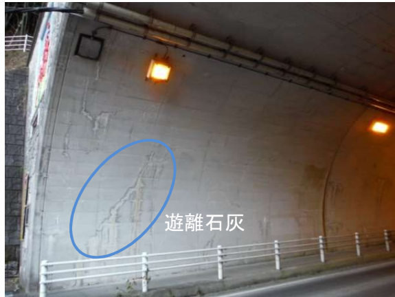
側壁のひび割れ状況 (S-001 下り側)
