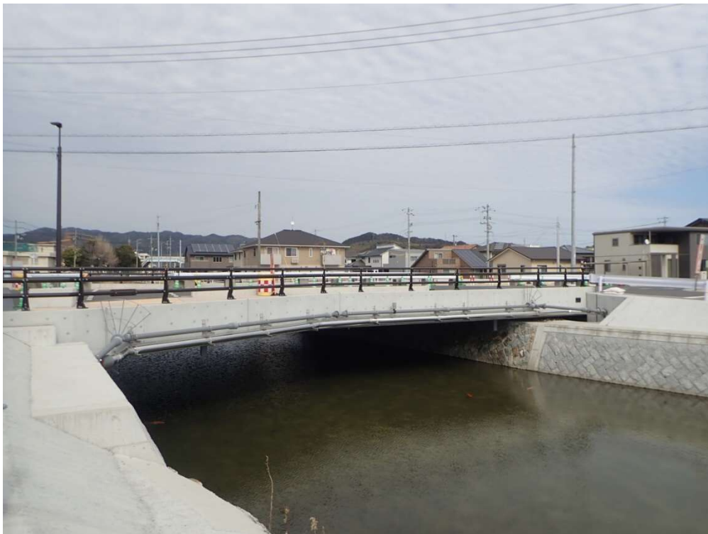
大海町橋 PC 橋 2018 年架設
