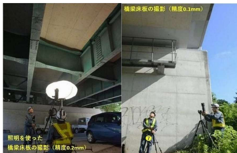
超望遠レンズによる高層構造物の外観検査技術
