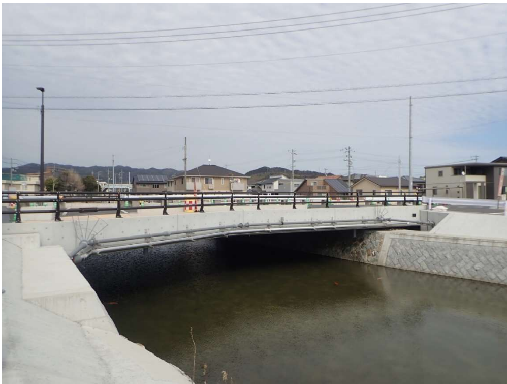
大海町橋 PC橋 2018年架設
