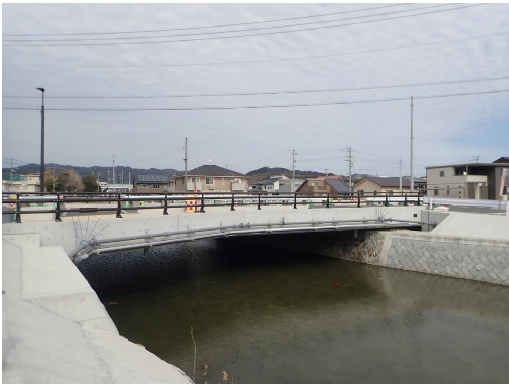
大海町橋 PC 橋 2018 年架設
