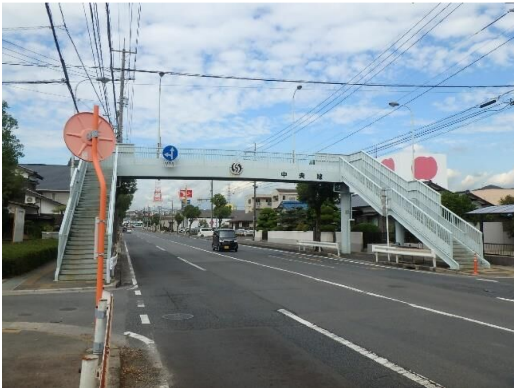
末武横断歩道橋 鋼橋 1971 年架設
