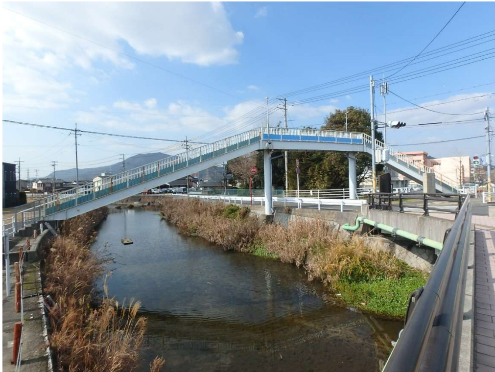
公集横断歩道橋 鋼橋 2005年架設
