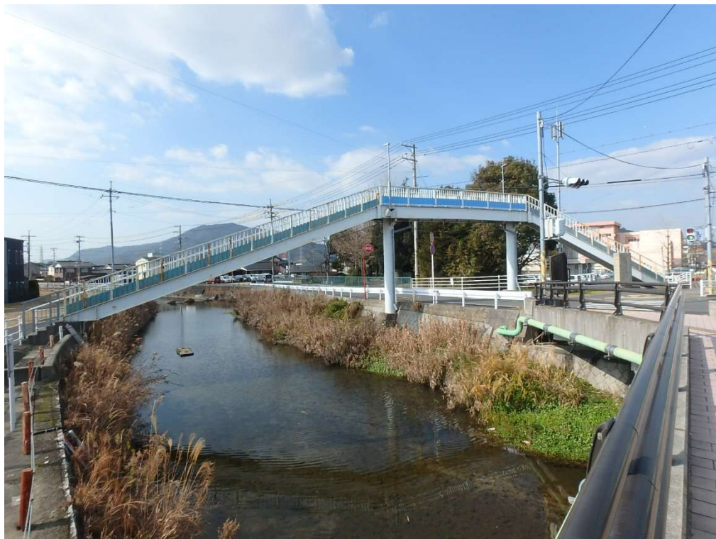
公集横断歩道橋 鋼橋 2005 年架設
