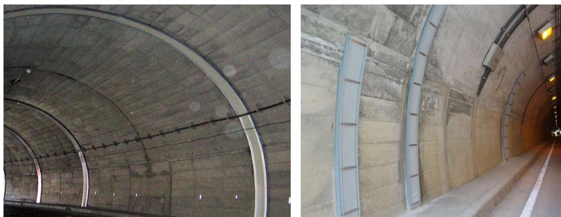
他トンネルの事例
