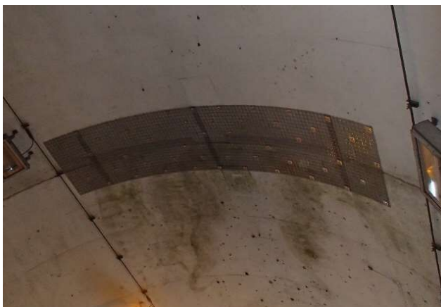
恋路トンネルの事例 (S-014)
