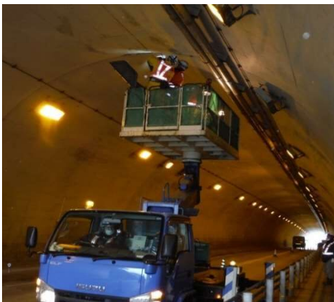
写真 2-1 恋路トンネル点検状況
