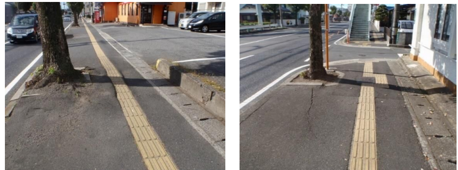
④ 段階的な道路整備を実施
