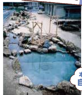
完成時のわくわく広場
