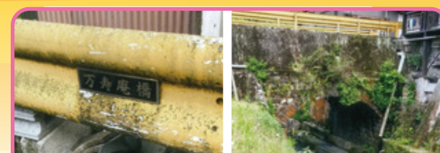
山中川にかかる「万寿庵橋(まんじゅあんばし)」は、大変珍しい石橋で、大正5年10月に建設され、現在も使用されています。山中川は、この橋の下を通り、末武川に合流します。
