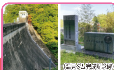
昭和26年から5年間かけて建設されました。えん堤のそばには、ダム建設の発案者の木原六郎さんをたたえ、「温見ダム建設の父」と刻んだ記念碑も建っています。
