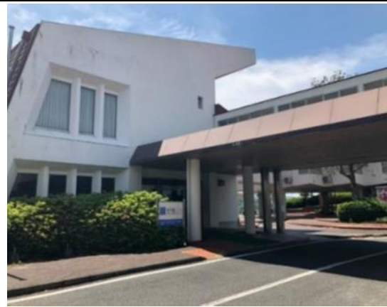
本館棟入口付近
