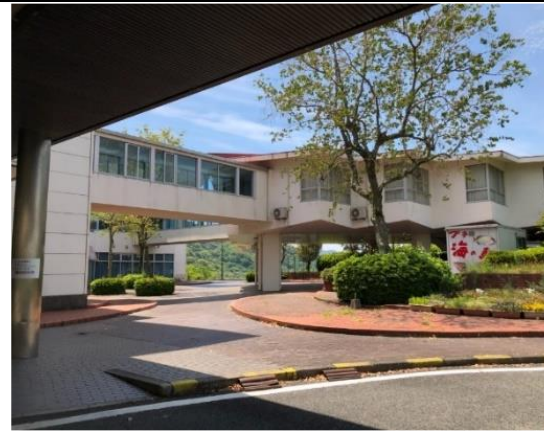
本館棟からの通路と宿泊棟
