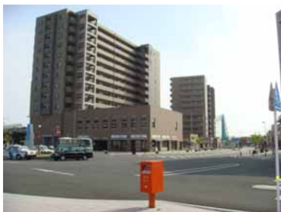
下松駅前地区市街地再開発ビル
