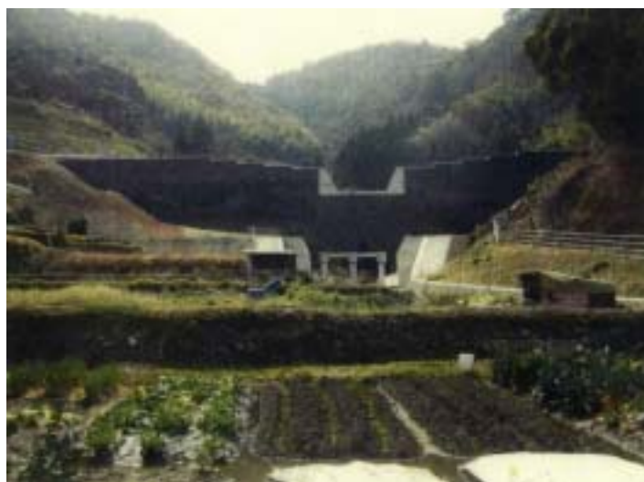
本浦地区砂防ダム
