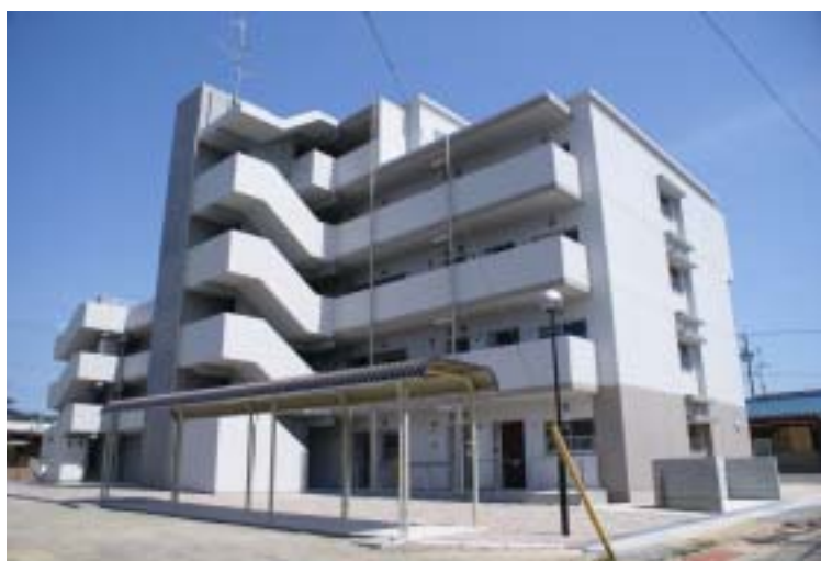
尾尻市営住宅
