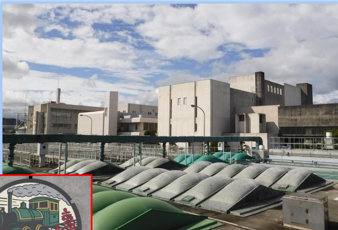
下松市浄化センター
