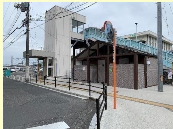
▲下松駅北口エレベーターとバリアフリースイール
