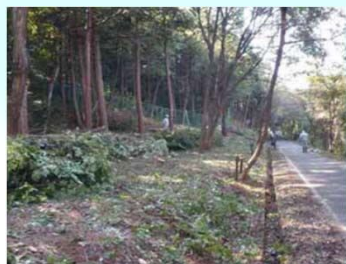
緩衝帯の整備
