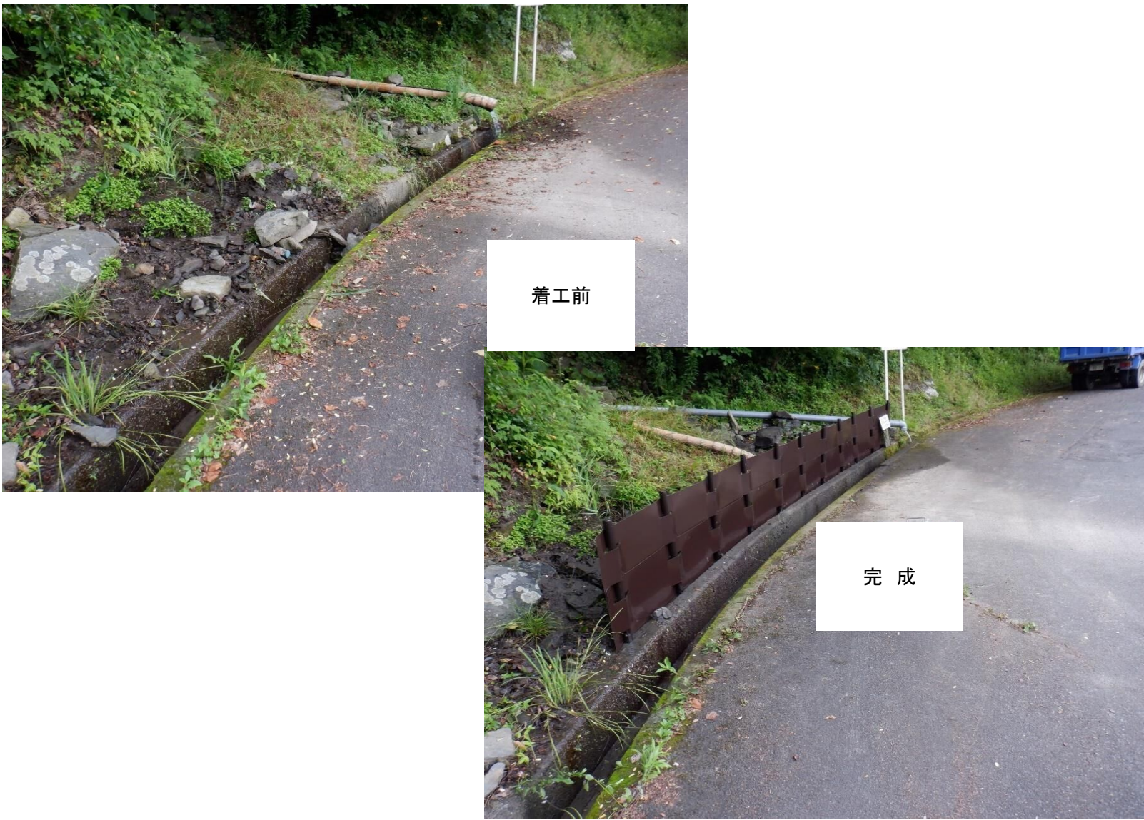
○林道等改良・補修工事事業 笠戸島地区土留（どどめ）柵設置ほか1件工事
