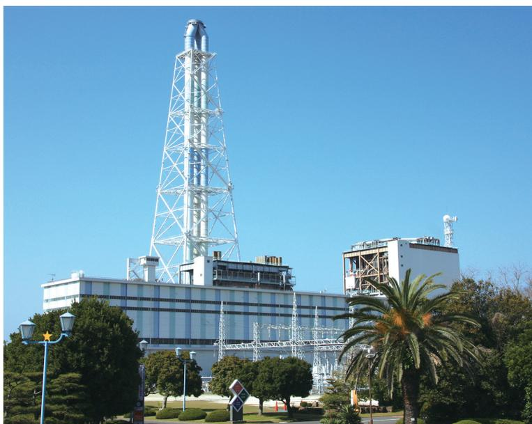
下松火力発電所は、昭和39年1号機の営業運転開始以来、地域の皆さまと共に歩んできました。現在は計画停止運用中ですが、重油と原油を燃料とした発電設備を1台設置しており、出力は最大時で70万kWです。火力発電所は、ボイラで燃料を燃やしてできた高温高压の蒸気により、タービン(羽根車)を高速回転(60回転/秒)させ、タービンに連結した発電機で電気を起こす仕組みとなっています。煙突の高さは200m、敷地は32万㎡で、東京ドーム約7倍の広さがあり、そのうちの1/4は緑地です。発電所内にある野球場、テニスコート、卓球場は地域のみなさまに開放し利用していただいています。
