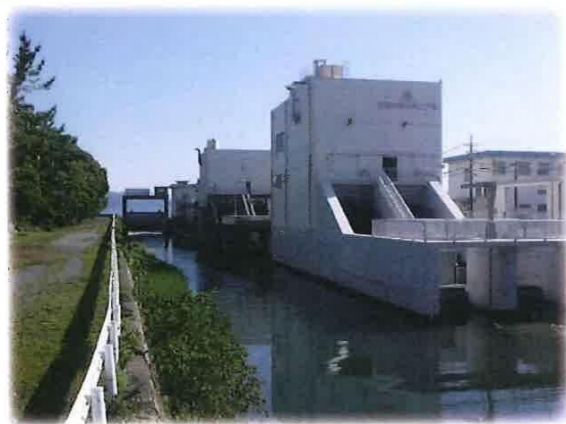
竹屋川ポンプ場
