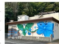
現・若宮ポンプ所
