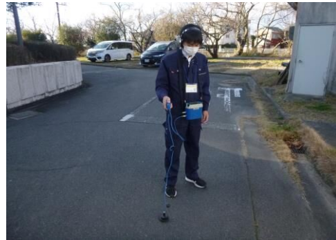
漏水調査業務の様子
