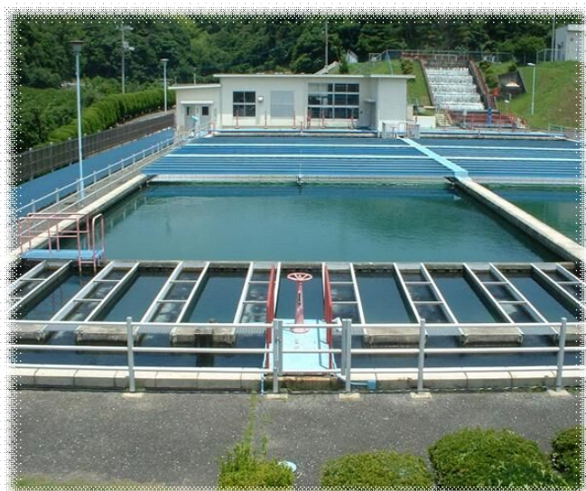
御屋敷山浄水場
