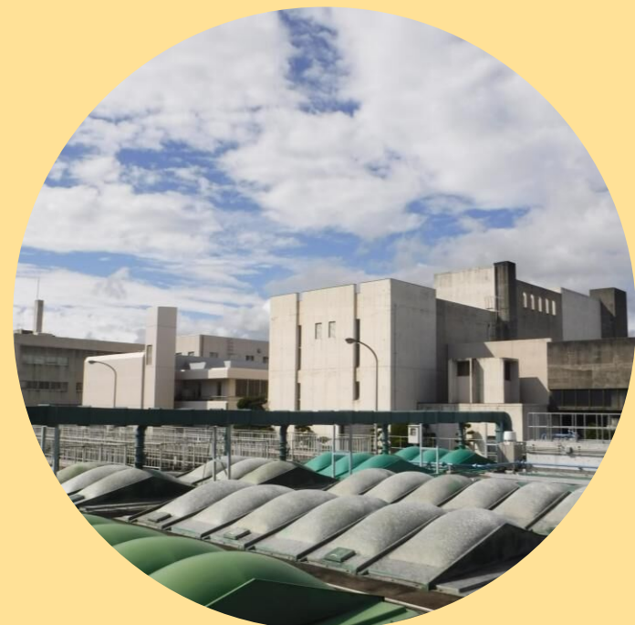
浄化センター
