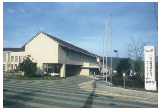
地域交流センター施設の改修
