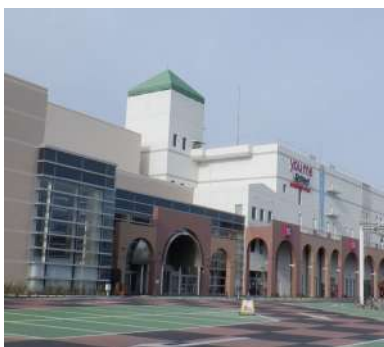
都市拠点施設の有効利用と 周辺環境整備
